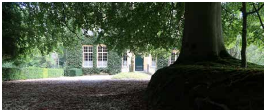
Een oprit - zuidwest - voert vanaf de Van Harinxmaweg naar de westzijde van het huis
