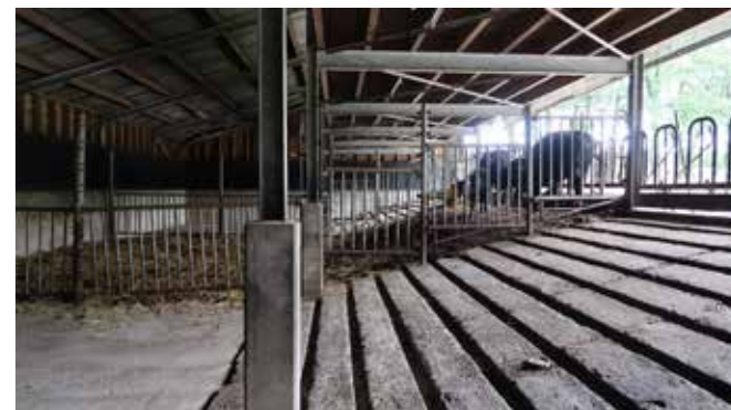
De gerestaureerde potstal - een van de weinigen die er nog zijn - waarin zich na de winter een 1,5m hoge laag ruwe stalmest heeft opgehoopt
